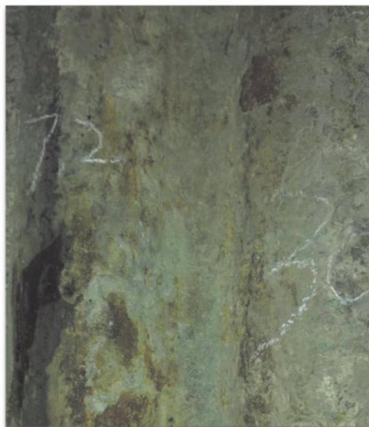
运行1年1个月后，煤含硫量3.5%，原普通涂层明显受到了严重的腐蚀，
