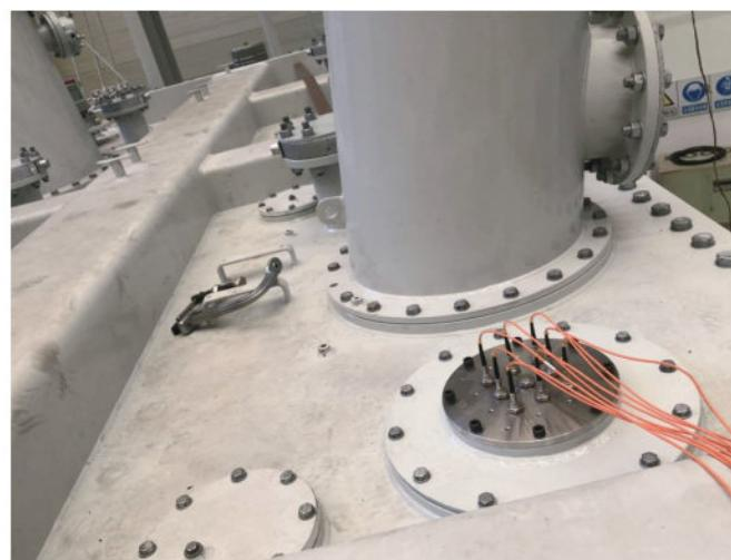
砷化镓光纤传感器和外部转接光缆的长度可>50m
